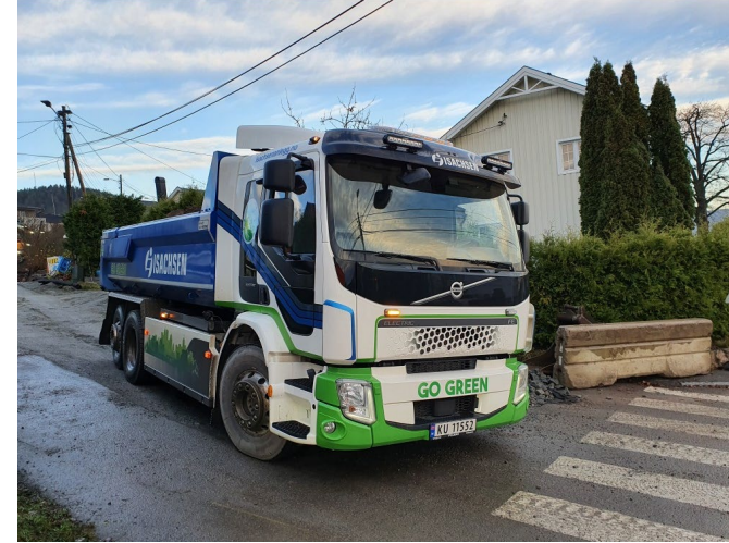
Bilde: Elektrisk lastebil benyttet for intern massetransport (t/r mellomlager) i VA-prosjekt for Drammen kommune.
