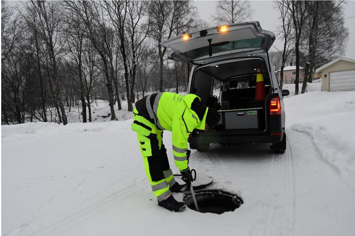
Lekkasjekontroll i praksis
