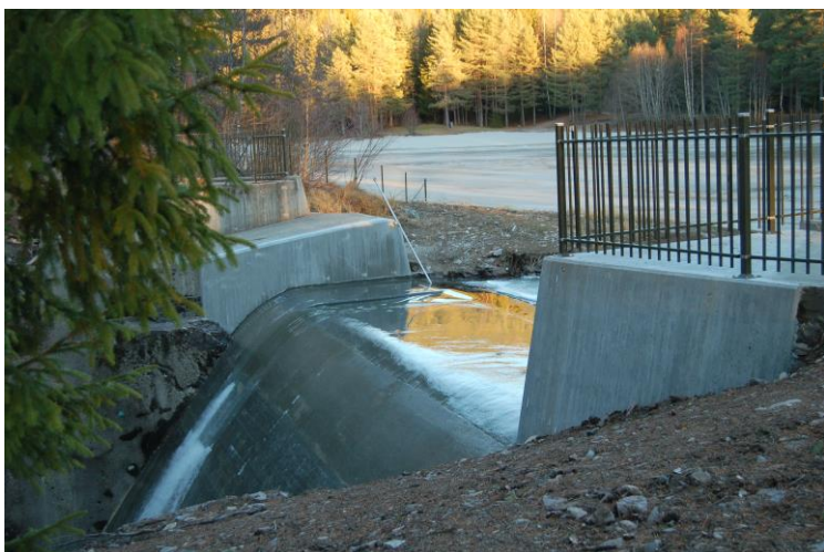
Bilde 3. Ferdig ombygd
