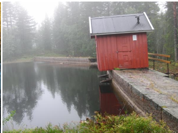
Bilde 6 Dam Solbergvann før rehabilitering
