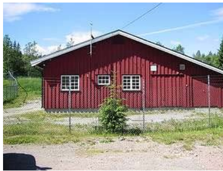
Kleivdammen behandlingsanlegg Kilde for foto: http://www.glitre.no
